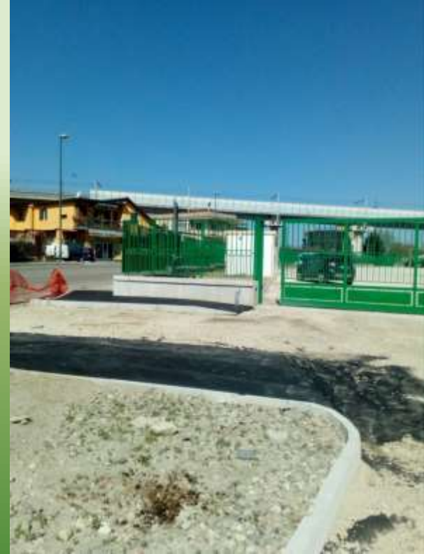
INGRESSO PRINCIPALE CDR
